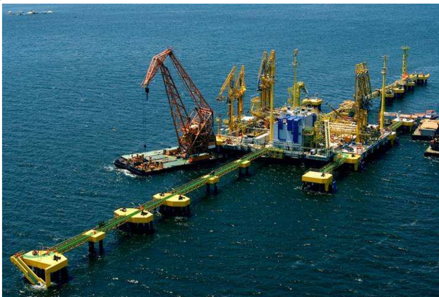
Vista Geral do Terminal – Final da Construção e Montagem - 22/jan/09.
