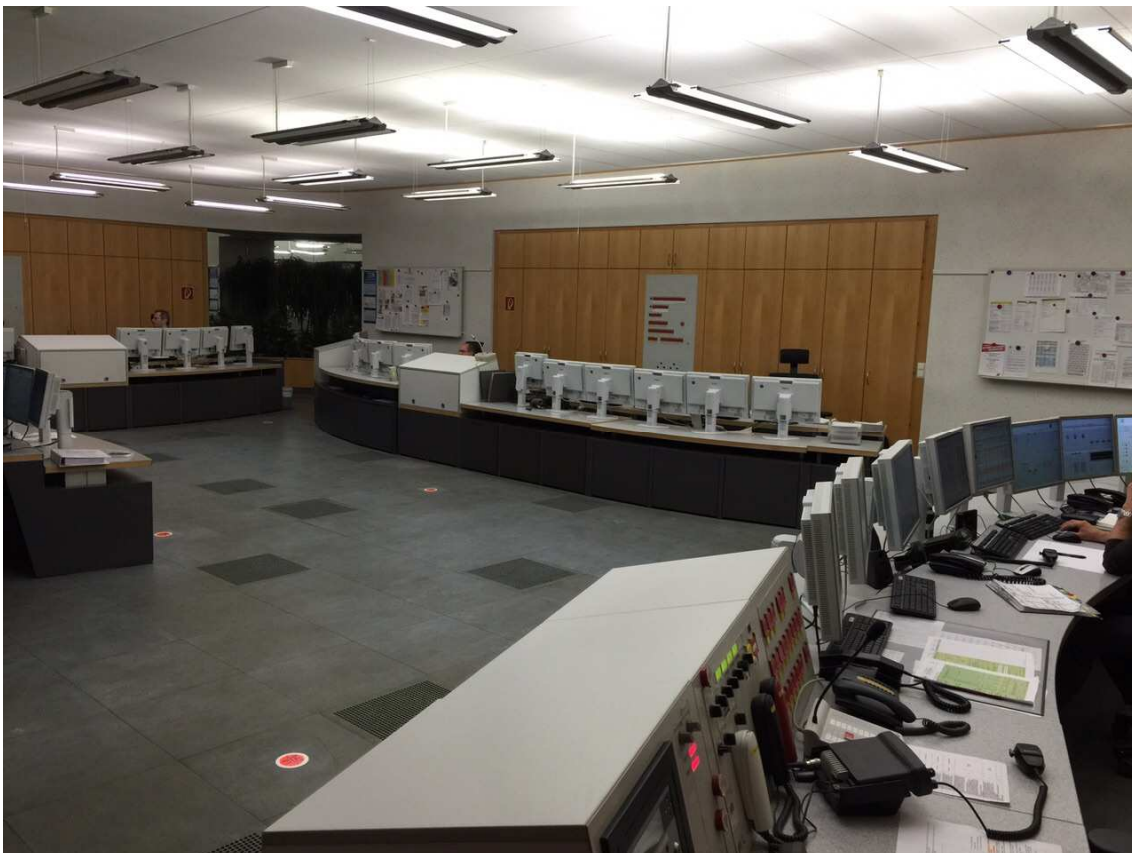
Figura 5. Layout da CIC da Refinaria de Holborn. Três “ilhas” distintas, para os setores de OH, OC e OT, cada uma com 5 pares de monitores.
