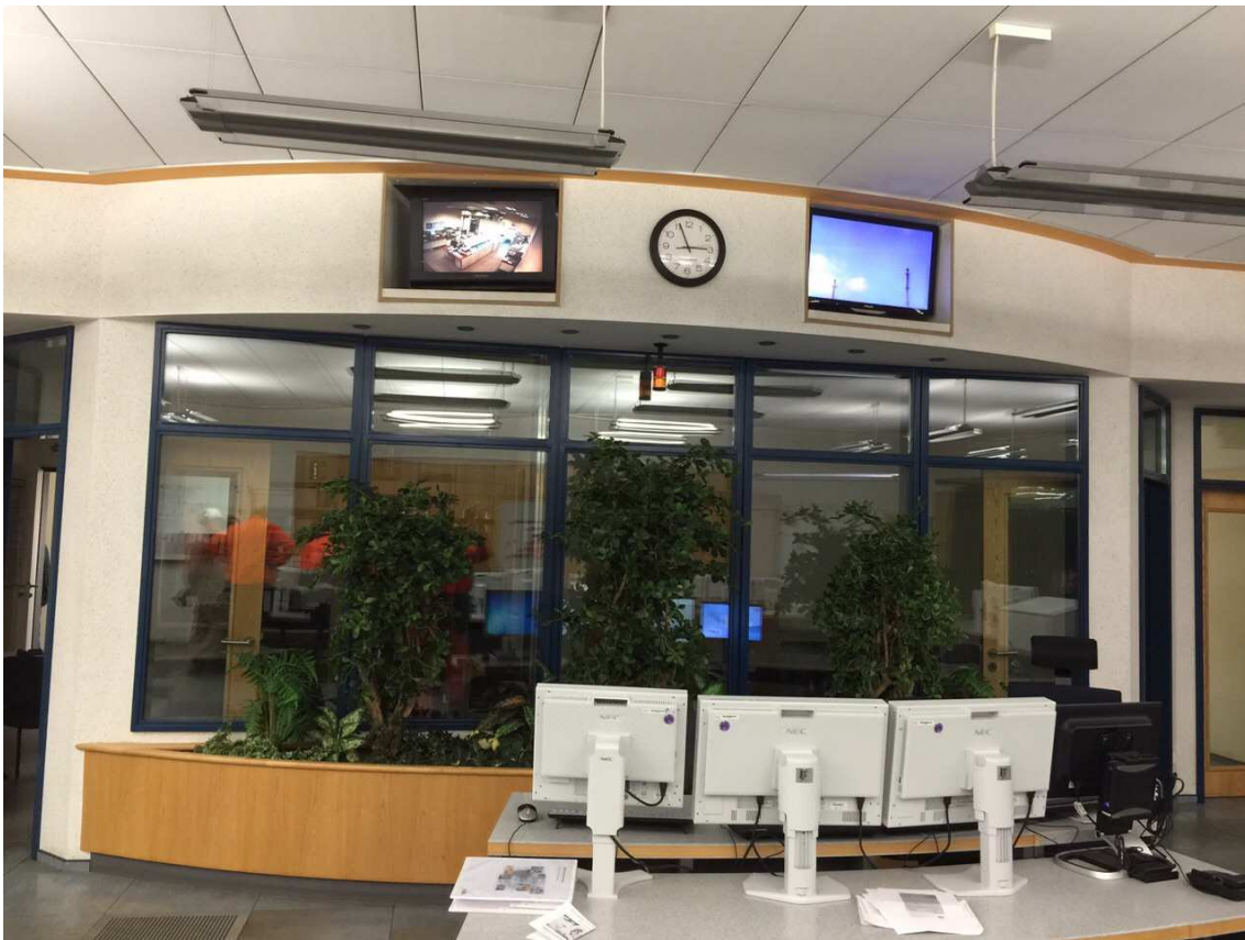
Figura 6. Monitores centrais para acompanhamento dos líderes de turno (supervisores). Observa-se ainda os dois únicos monitores de vídeo utilizados para monitoramento por câmeras de toda a refinaria.
