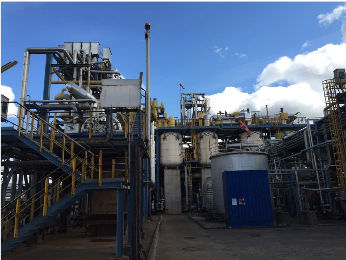
7. Sistemas de combate a incêndio
